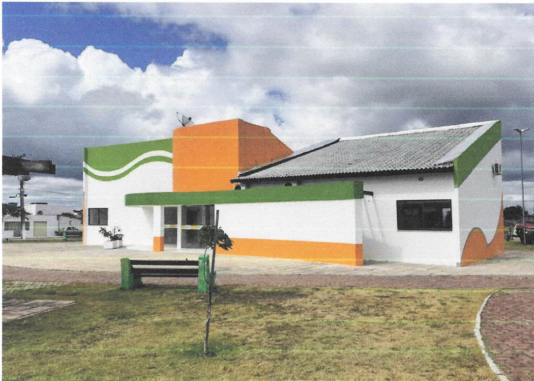
Foto 14 – Pintura da fachada da SECRETARIA. (DEPOIS)
