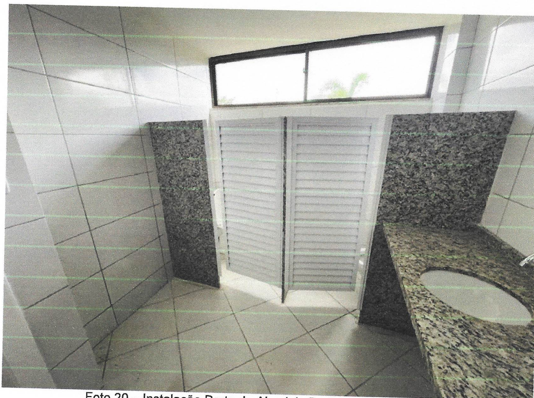
Foto 20 – Instalação Porta de Alumínio Banheiro, SECRETARIA.
