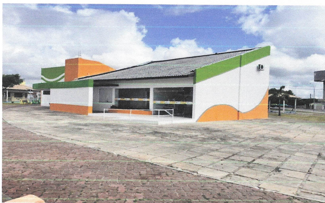
Foto 02 – Pintura da Fachada Principal BIBLIOTECA. (DEPOIS)
